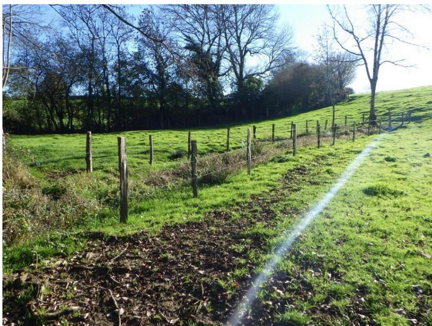
*Photo 22 : Exemple de pose de clôture, protection de source et berge sur le Lambon au lieu-dit « La Chaume »*
