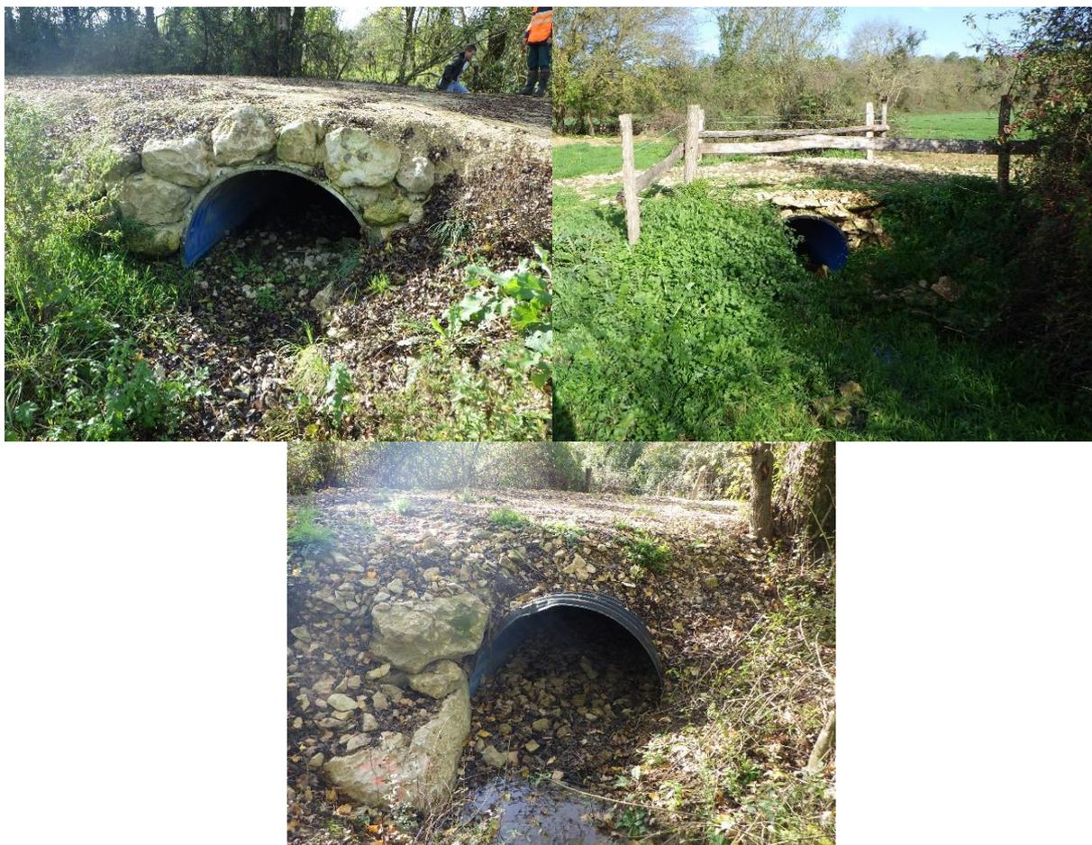
*Photo 4 : Buses mises en place sur le ruisseau de la Roche Pichet avec recharge granulométrique à l'intérieur*
