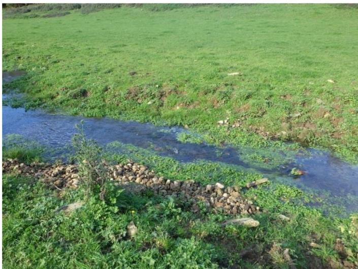
*Photo 24 : Mise en place de recharge granulométrique fine sur le Lambon amont au lieu-dit « La Bertaudière »*
