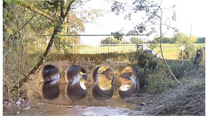
Après : réhausse de la lame d'eau de 10 cm pour supprimer la chute par une recharge en pierres en aval et reprise de l'étanchéité.
