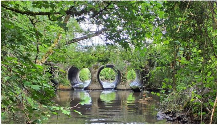
Avant : présence d'une chute en sortie d'ouvrage et problème d'étanchéité.
